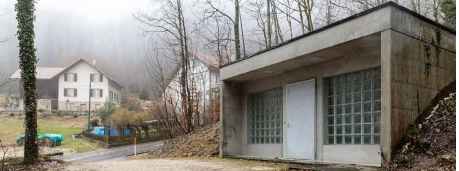
Das alte Wasserreservoir «Weberhüsli» ist bald Vergangenheit und wird durch ein neues ersetzt.
