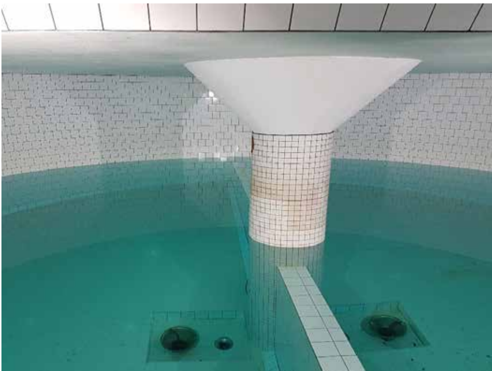
Eines der zwei Wasserbehälter im alten Wasserreservoir.
